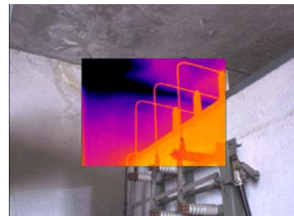
Imagen termográfica y de luz visible fusionadas con la tecnología IR Fusión de la cámara Ti25.
